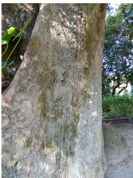
照片 3：避雷針之部分鐵線已嵌入樹木中
