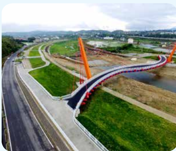
●西湖溪環境整體營造 - 銅鑼景觀橋
