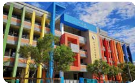
●后庄國小老舊校舍拆除整建完工
