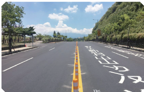
●苗 29 線 (後龍、苗栗部分路段) 改善工程已完工
