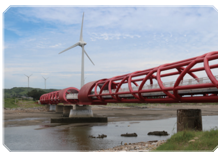
●西湖溪後龍段自行車橋完工
