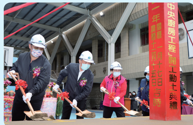
●照南國小新建中央廚房動土，完工後營養午餐供量將是全縣最大。
