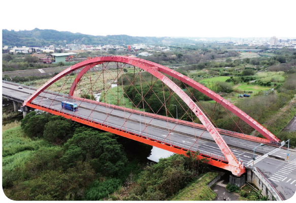
●頭份大橋將全橋更換懸索並以防蝕塗裝維護鋼構，確保交通安全。
