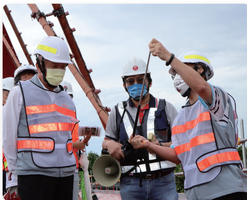
●縣長徐耀昌視察未來可望成為橋梁養護新標竿的頭份大橋改善工程。
