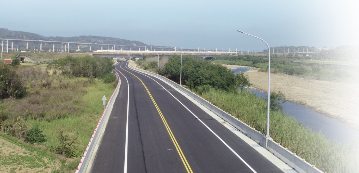
●道路完工現況。
