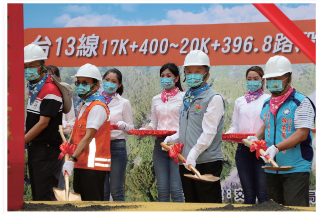
●台 13 線造橋、頭屋段拓寬工程動土，完工後可望打通瓶頸。
