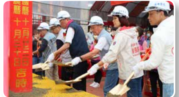
●頭份戶政事務所開工動土。
