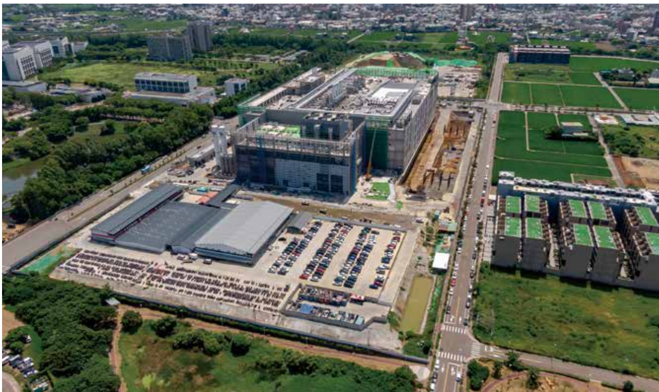
台積電廠房新建工程
