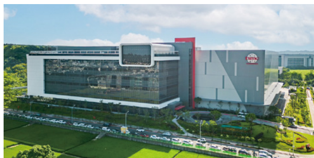
▲竹南科學園區台積電廠區興建中
