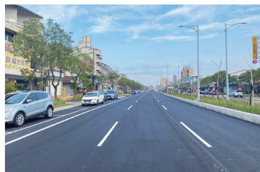
▲竹南鎮環市路人本環境改善工程施作中。
