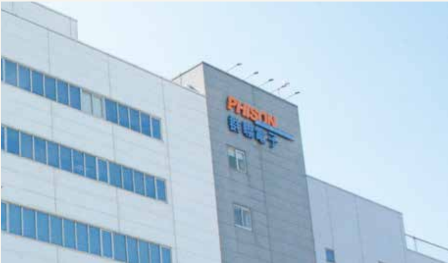
群聯電子股份有限公司位於竹南鎮的總部大樓
