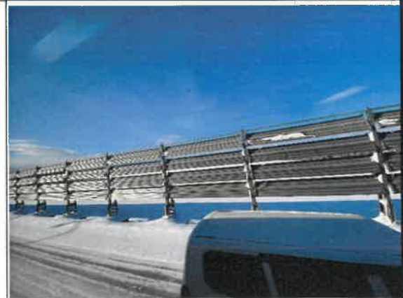
鐵製圍欄，形成天然雪崩屏障及防止野生動物路殺事件。
