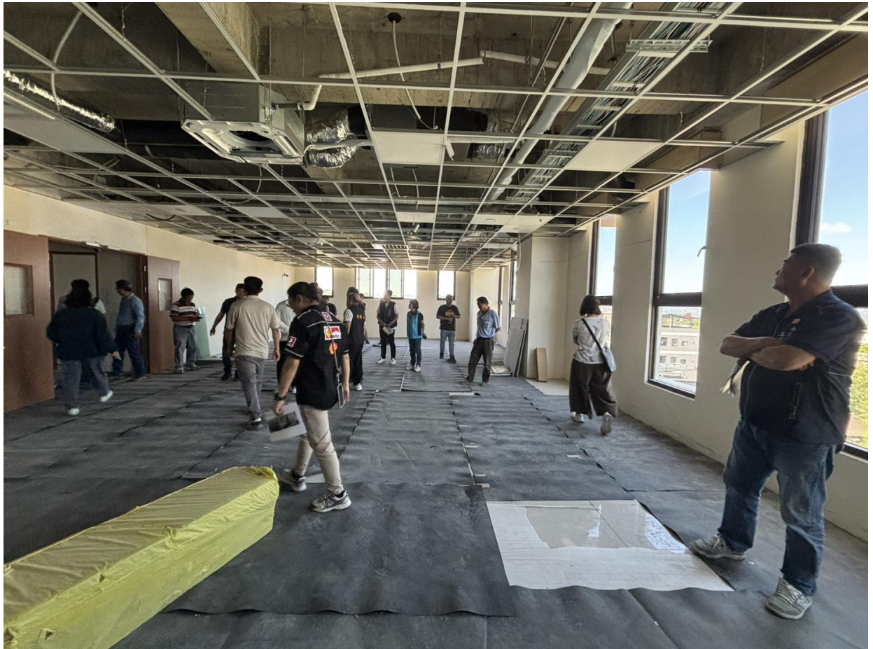
▲現場勘查確認已竣工情形，建議後續室內裝修方向，並針對現狀改進。
