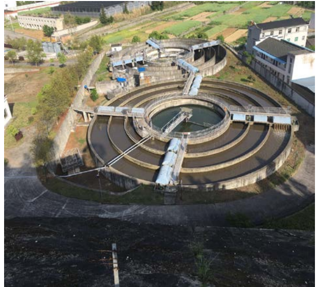
許家沖村之污水處理廠
