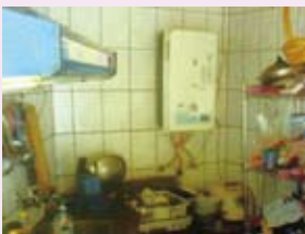
▲ CF式熱水器裝設錯誤之排氣管範例圖
