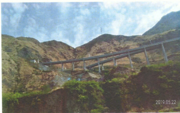
雅西高速公路的高架橋
