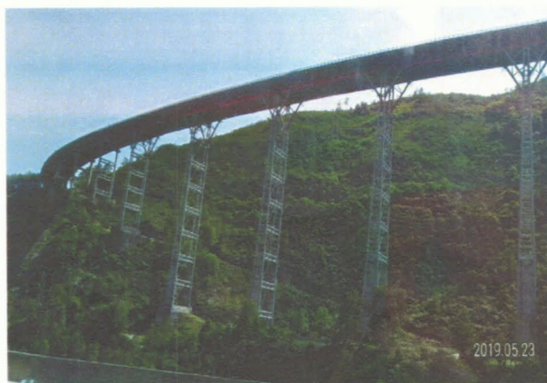
雅西高速公路高架橋
